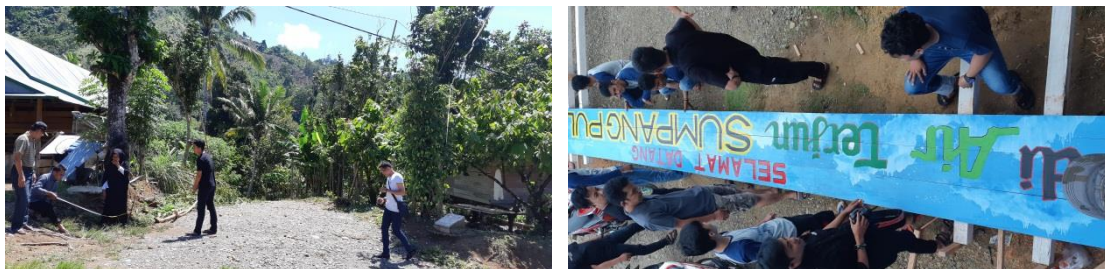
Gambar 2. Pengukuran Lokasi dan Pembuatan Gapura
