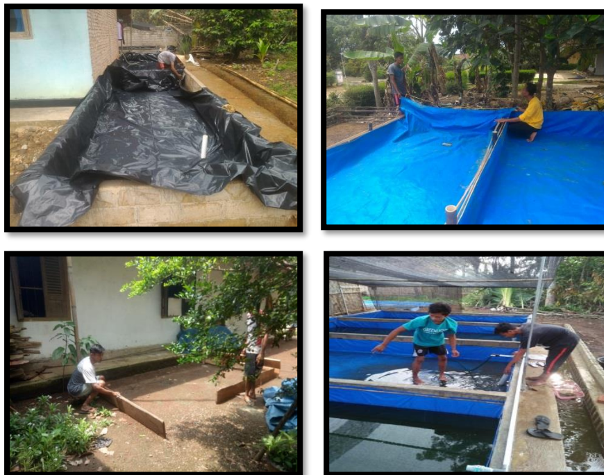
Gambar 6. Proses pembuatan dan instalasi kolam pembenihan ikan Lele Mutiara
