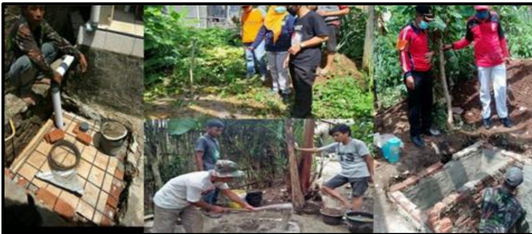
Gambar 5. Pembangunan jamban sehat
