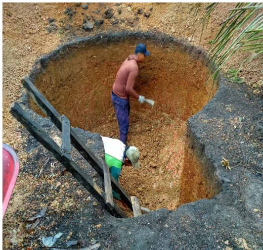
Gambar 5. Penggalian untuk digester
