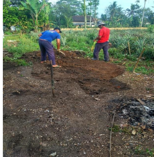
Gambar 4. Proses pembersihan Tempat Galian Digester
