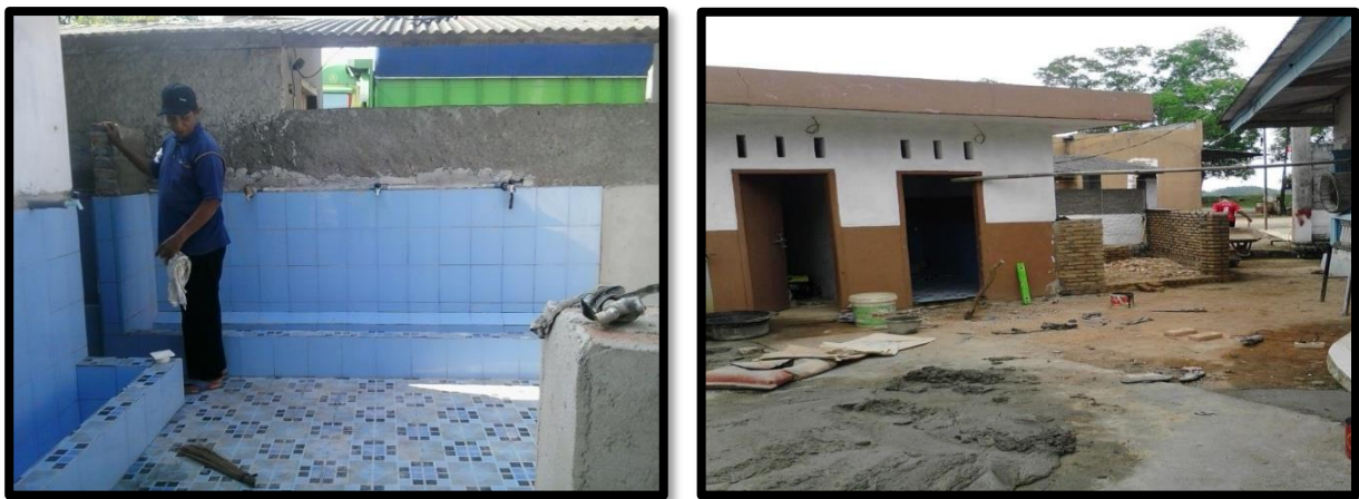
Gambar 13. Toilet atau Kamar Mandi dan Tempat Wudhu Sedang Dalam Proses Finishing.
