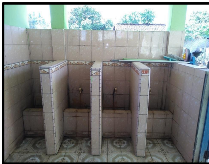
Gambar 8. Tempat Toilet Sebelum Renovasi (Masjid Khoirul Huda).
