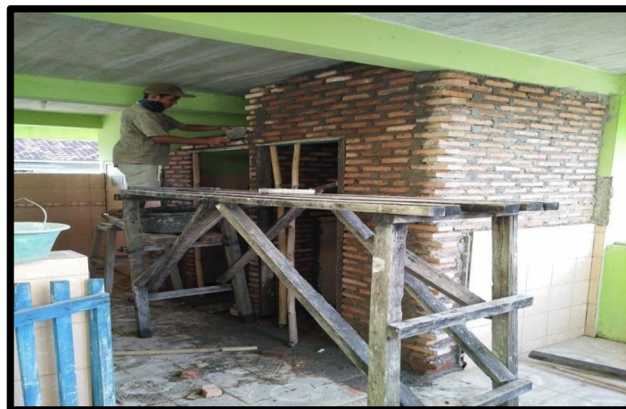
Gambar 10. Toilet sedang direnovasi (Masjid Khoirul Huda).
