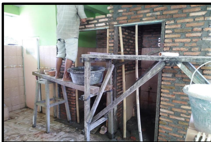
Gambar 11. Toilet Sedang direnovasi (Masjid Khoirul Huda).
