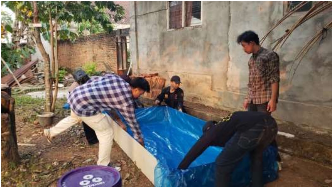
Gambar 6. Proses Pelapisan Bagan Dengan Plastik
