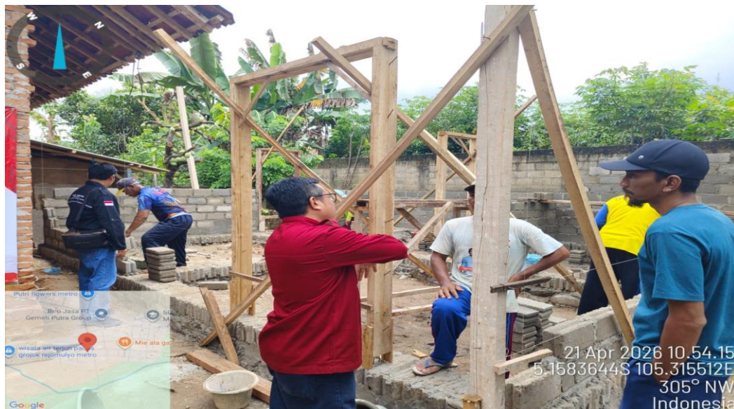
Gambar 3. Penjelasan Mengenai Teknis Pelaksanaan Pekerjaan Bangunan (Sumber: Tim Abdimas, 2026)
