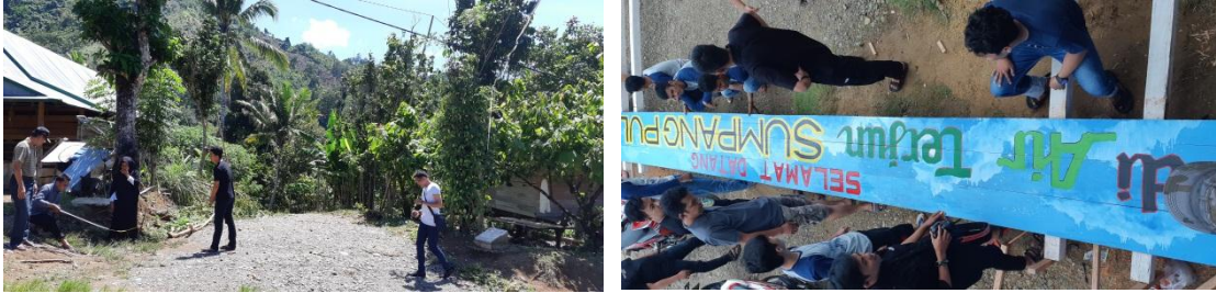
Gambar 2. Pengukuran Lokasi dan Pembuatan Gapura
