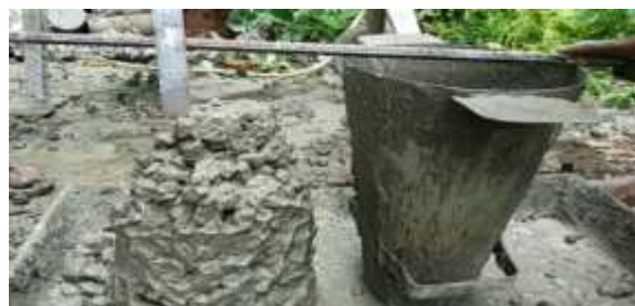
Gambar 1. Pengujian Slump Test
