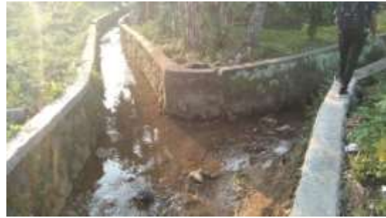
Gambar 3. Lokasi existing pertemuan saluran (Sumber: Dokumentasi Penelitian, 2022)
