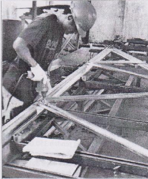
Gambar : 3 Foto Perakitan Rangka Atap Baja Ringan ( Sumber : Dok. PT. Pryda Indonsia terbitan majalah Rangka Atap Baja Ringan )
