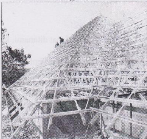
Gambar 4. Perakitan Konstruksi Rangka Atap Baja
