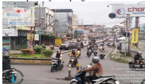
Gambar 3. Kondisi Arus Lalu Lintas Saat Palang Kereta Tertutup (Leni, 2025)
