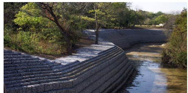
Gambar 2. Contoh Pengaman Dinding Sungai Jenis Gabion
