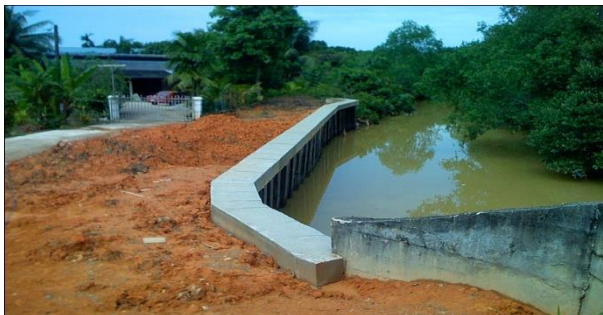
Gambar 4. Contoh Salah Satu Pengaman Dinding Sungai Jenis Sheet Pile
