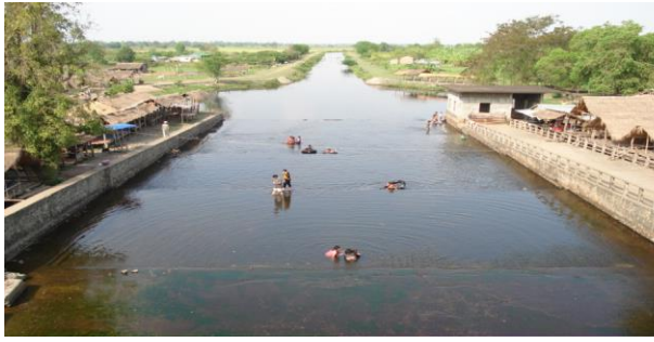
Gambar 3. Contoh Salah Satu Pengaman Dinding Sungai Jenis Retaining Wall
