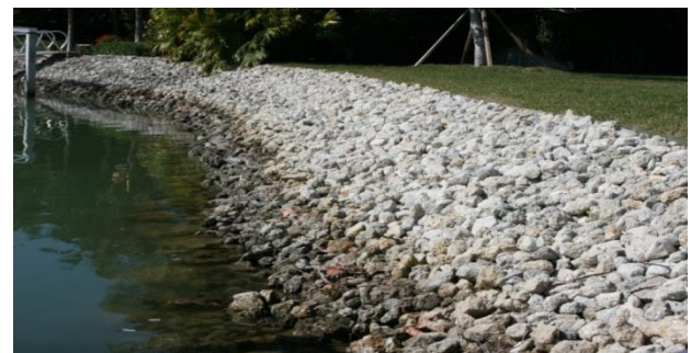
Gambar 1. Contoh Pengaman Dinding Sungai Jenis Riprap
