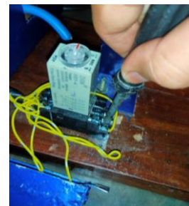
Gambar 6. Pemasangan timer relay .
