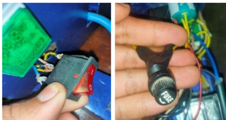
Gambar 4. Pemasangan saklar utama dan sekring.
