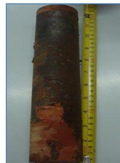
Gambar 2. Potongan tube boiler/ economizer yang mengalami korosi dan terjadi penipisan dinding pipa.
