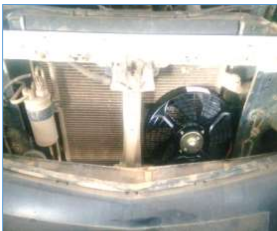
Gambar 5. Instalasi AC setelah penambahan fan
