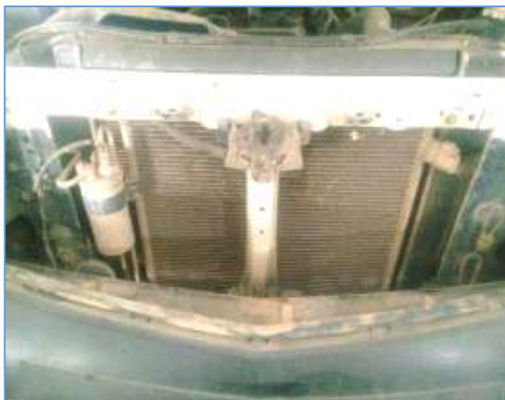
Gambar 4. Instalasi AC sebelum penambahan fan
